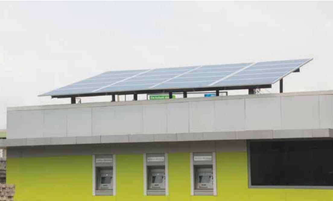
**“A RELIABLE SOLAR HYBRID SYSTEM, WITH BATTERY BACKUP, WAS REQUIRED TO POWER DIAMOND BANK’S ATMS THROUGHOUT THE DAY, AS WELL AS OPERATE THE LOW-VOLTAGE DEVICES REQUIRED AT NIGHT.”**
